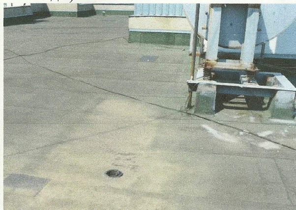
Фото №5-6. Отсутствуют/повреждены защитные решетки на воронках внутреннего водостока
