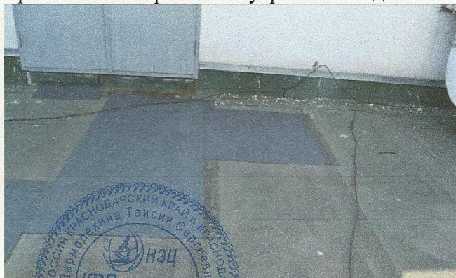
Фото №7-8. Участки ремонта покрытия кровли путем наклейки заплат
