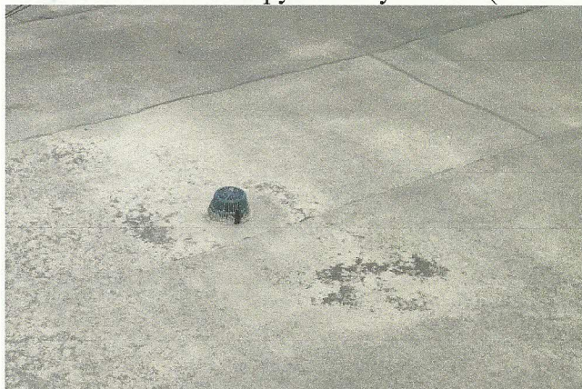
Фото №5-6. Отсутствуют/повреждены защитные решетки на воронках внутреннего водостока
